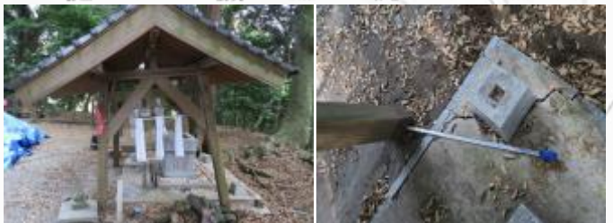
図-3 熊本地震時に報告された手水舎の跳躍現象
